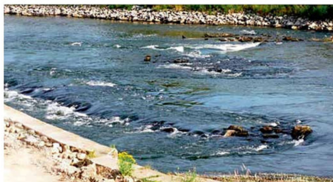
Die aktuelle Situation in Donauwörth bei Niedrigwasser. Die Fundamentreste sollen durch die Sicherungsmaßnahmen überstaut werden.
