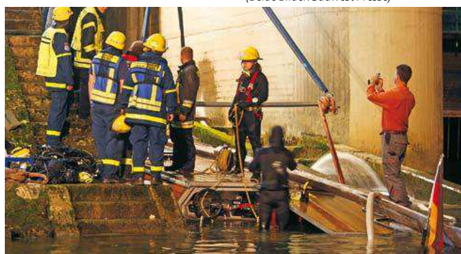
Voller Einsatz von Feuerwehr und THW. (Beide Bilder: Südwest Presse)
